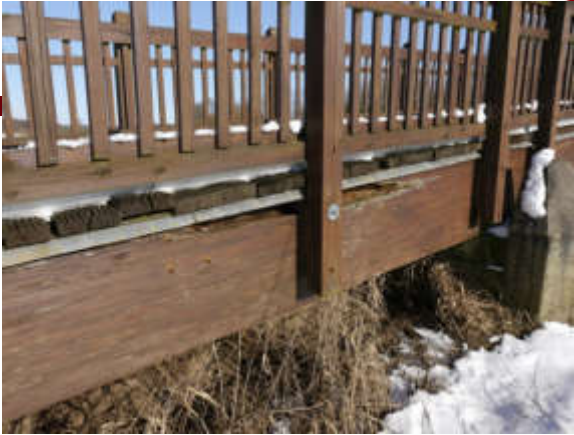
Extreme Schäden der Längsträger durch Verfaulung
