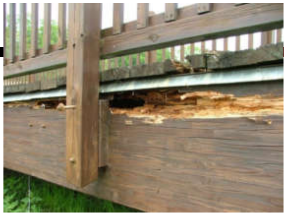
Extreme Schäden der Längsträger durch Verfaulung
